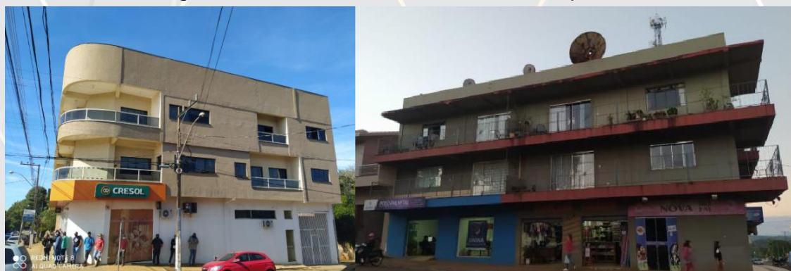
Figura 2 - Fachadas dos Edifícios do Grupo 1
