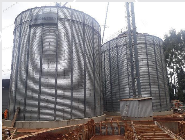
Figura 8 – Visão ampla das bases dos silos.
