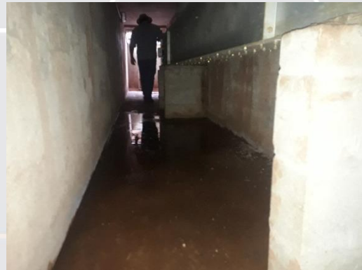
Figura 11 e 12 – Infiltração nos tuneis dos silos.
