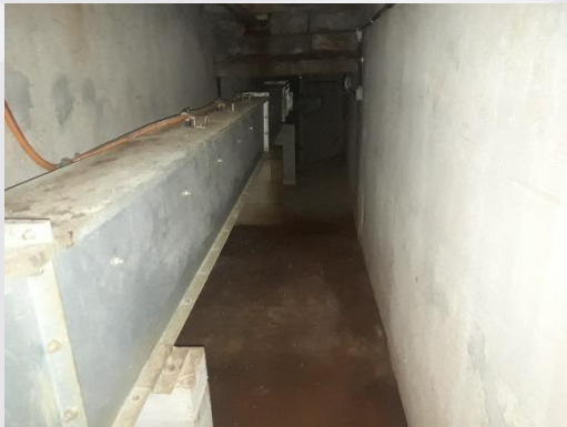
Figura 11 e 12 – Infiltração nos tuneis dos silos.
