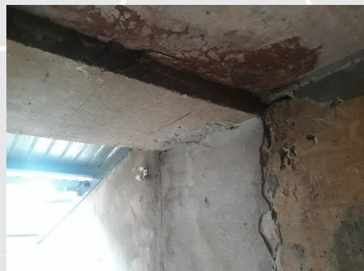
Figura 13 e 14 – Espaçamento para recalque nas bases de silos.
