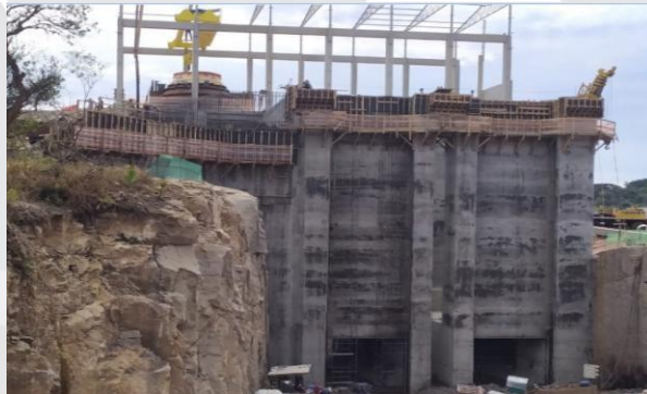
Figura 3: Trabalho em altura na sucção da casa de força da PCH
