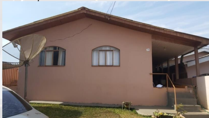
Imagem 1 - Foto da edificação
